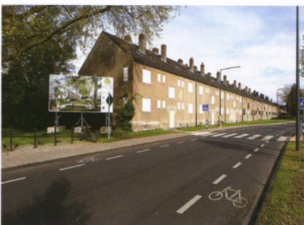
Häuserreihe in der Rochusstraße kurz vor dem Abrissterrain
