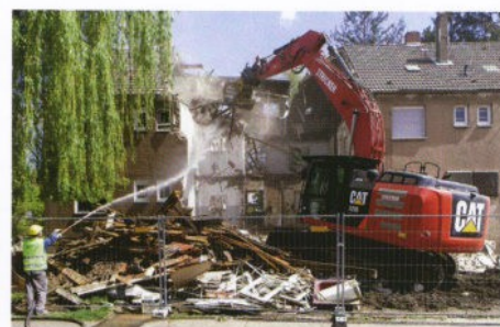
Abrissbeginn des ersten Bauabschnittes, Peter-Franzen-Straße, Ecke Gerhard-Bruders-Straße
