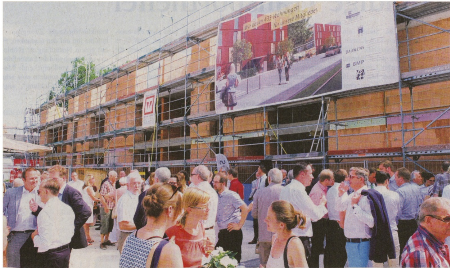
Eines der Gebäude des ersten Bauabschnitts der Ossendorfer Gartenhöfe
